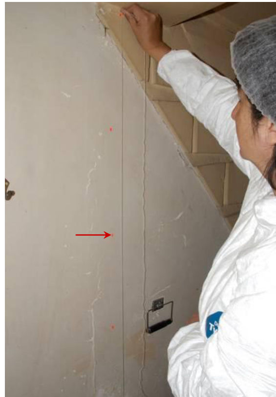
Figura 8: instalación de matriz cartesiana virtual en muro este. Los puntos rojos indican unidades de 30 x 30 cm.
