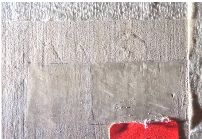
Figura 61 (superior izquierda): conjunto 2 después de la intervención. Tomada con luz rasante para intensificar los efectos en la superficie.
