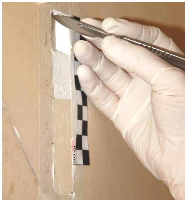
Figura 16: ejecución de la ventana VE1, en el muro este del Baño 2, donde se visualizan los estratos a, b, c y d.
