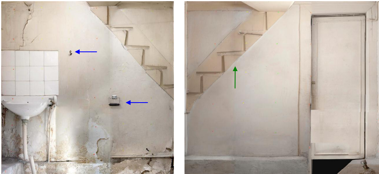
Figura 5: imagen izquierda muro este; imagen derecha muro oeste. Las flechas azules indican la ubicación de los dispositivos enclavados en el muro. La flecha verde, el rasgo dejado por la escalera de servicio una vez que fue desmontada. Nótese los problemas de humedad que presenta el muro este en su base, los cuales están asociados al ducto de agua y se extienden hacia el muro norte; están actualmente activos.
