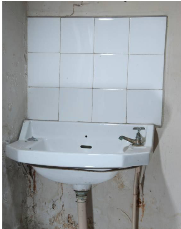
Figura 43: situación actual de la zona del lavamanos
