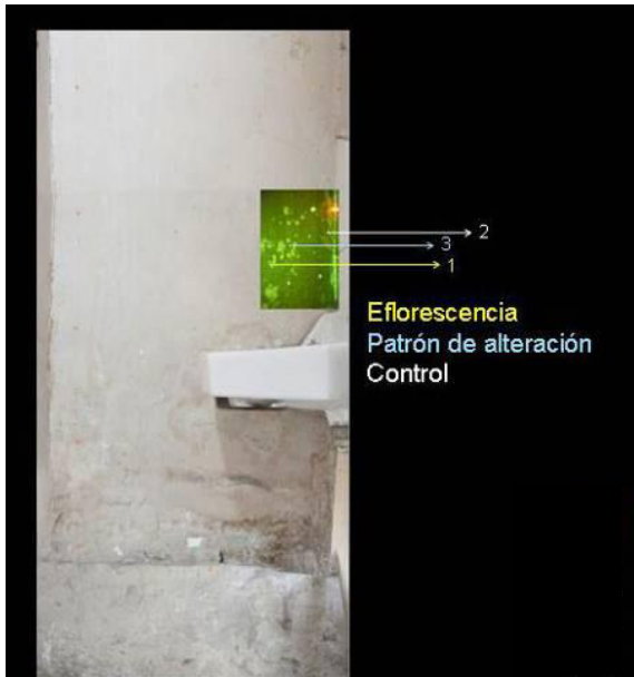
Figura 12: localización de muestras en muro norte.
