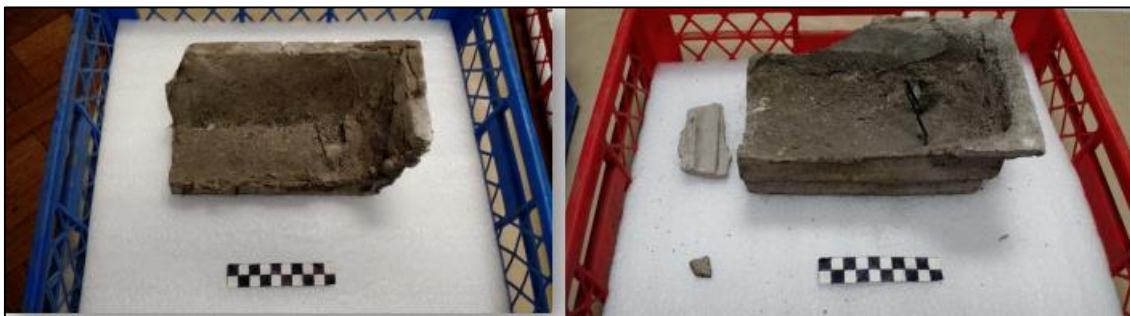
Reparación de ménsulas del inmueble de Londres 38
