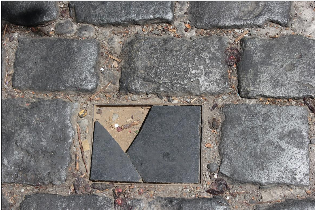
Placas deterioradas del memorial de calle Londres
